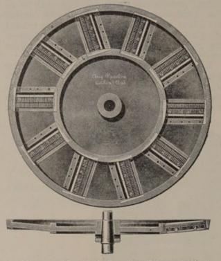
Abb. 474. Schneidscheibe einer Rübenschnitzelmaschine mit 10 Messerkästen.
