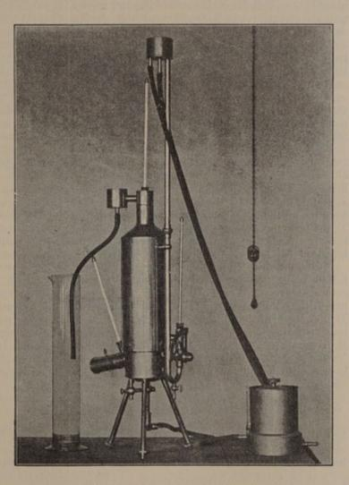
Abb. 274. Junckersches Kalorimeter.
