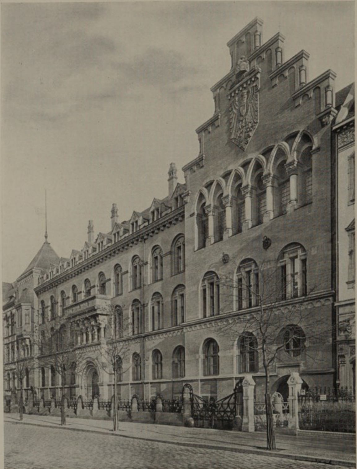
Abb. 1. Verwaltungsgebäude des Reichsgesundheitsamts in Berlin, Alopitodstr. 18.
