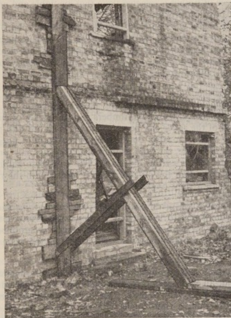
Fig. 127. A raking shore
