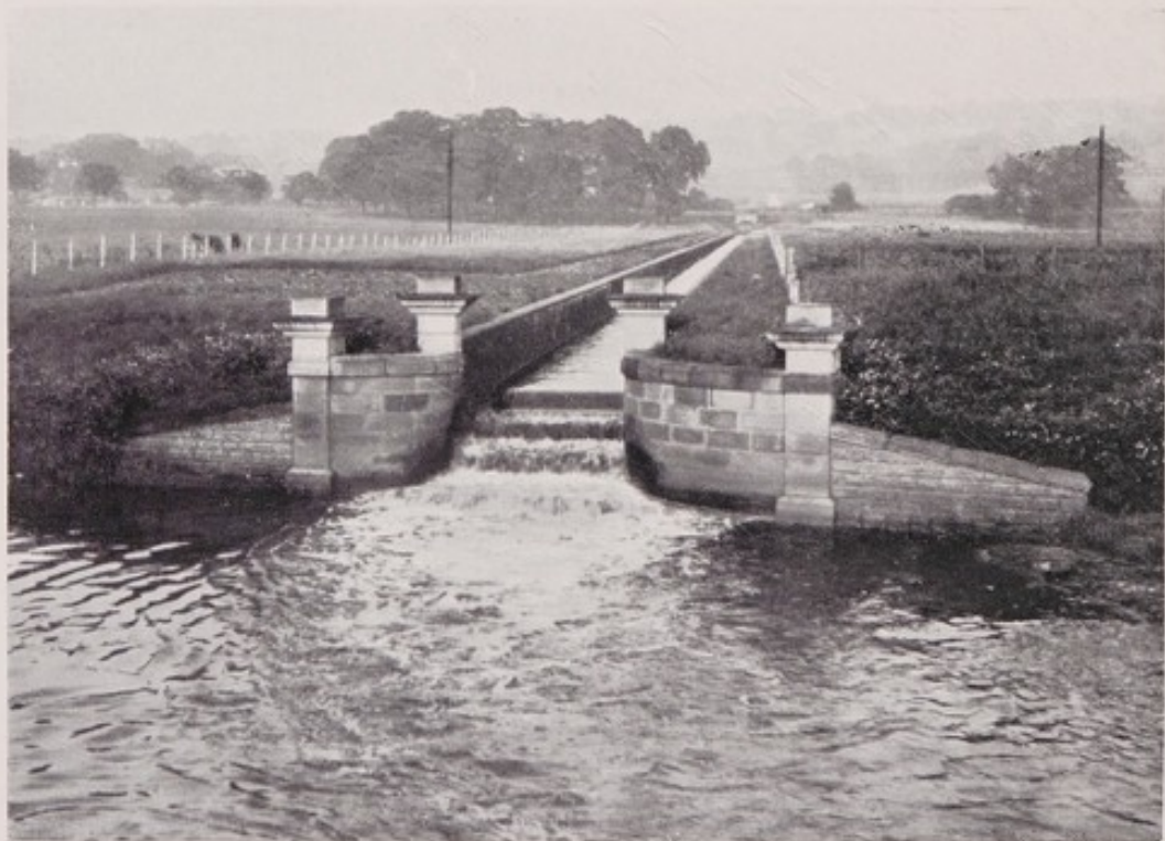
MAIN EFFLUENT CONDUIT DISCHARGING TO RIVER AIRE.
