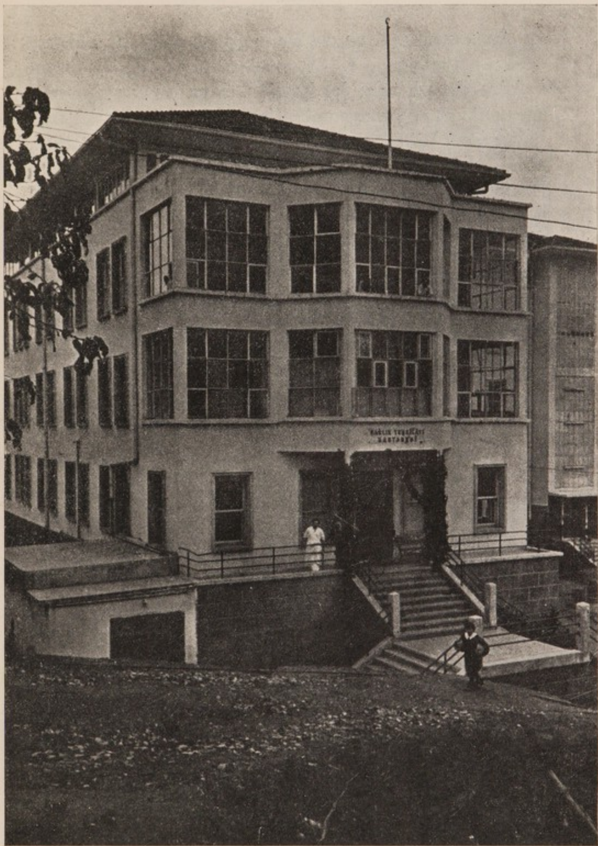
Hôpital de la corporation ouvrière à Zonguldak
