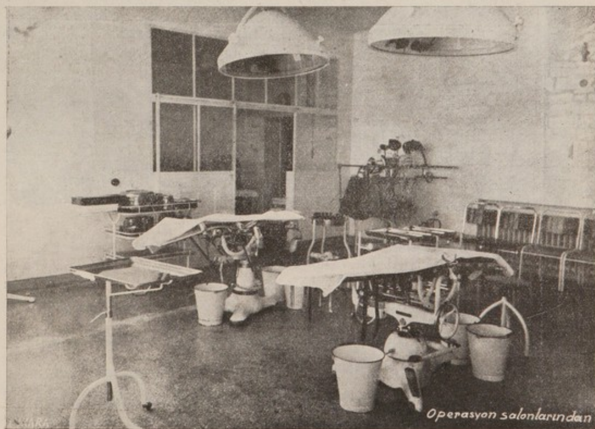
Une des salles d'opération. hôpital d'Ankara
