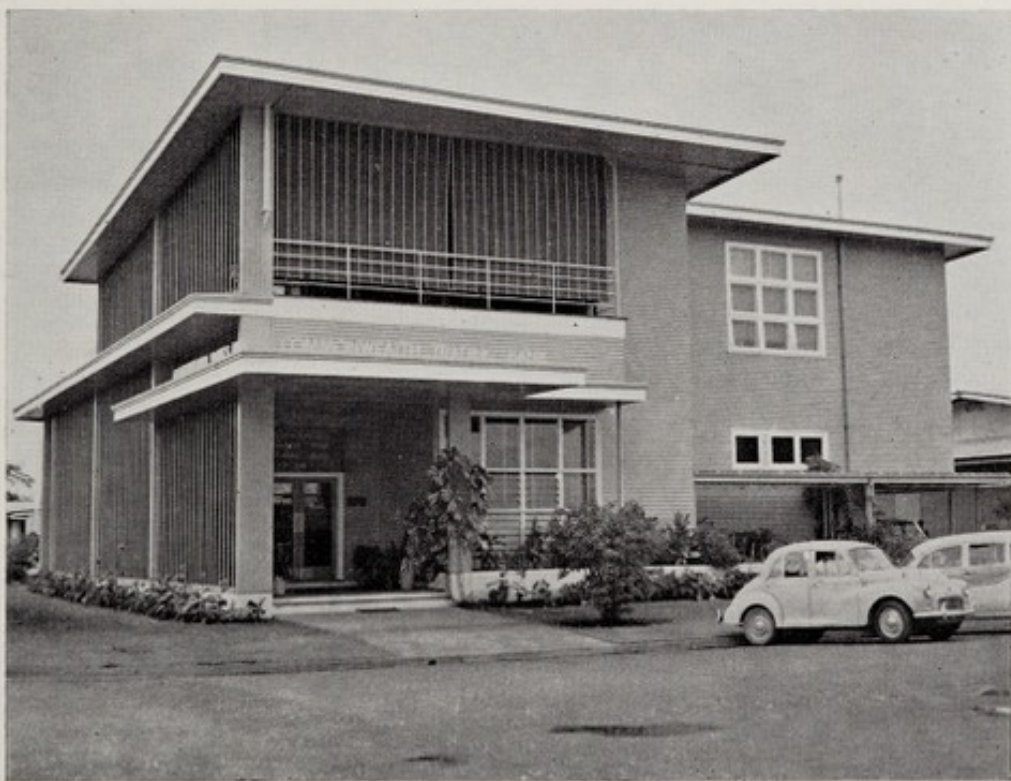
Commonwealth Bank, Lae.
