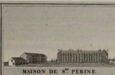
MAISON DE S t PÉRINE
