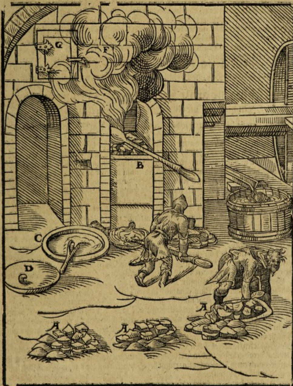
Abgewogen Kupffer und Bley zu den Fürschlägen / A. Der Fürschlofen / B. Die Kupfferpfanne/ darin die Fürschstücke gegossen werden/ C. Das Fürschstück / D. Des Schmelzers/ E. Das Gewölbe/ darin der Rauch und Staub gefangen wird / F. Das Dornlein/ das aus der Staub ausgeräumt/ G.
