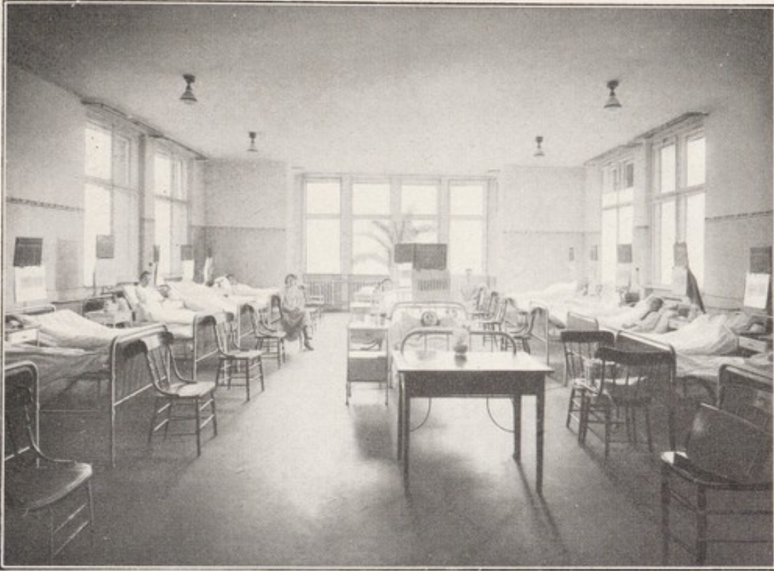
Isr. Krankenhaus, Gynäkologische Abteilung, Krankensaal.
