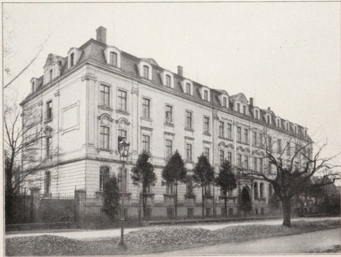
Isr. Altersversorgungsanstalt, Julius u. Anna Schottländer'sche Stiftung, Straßenansicht.
