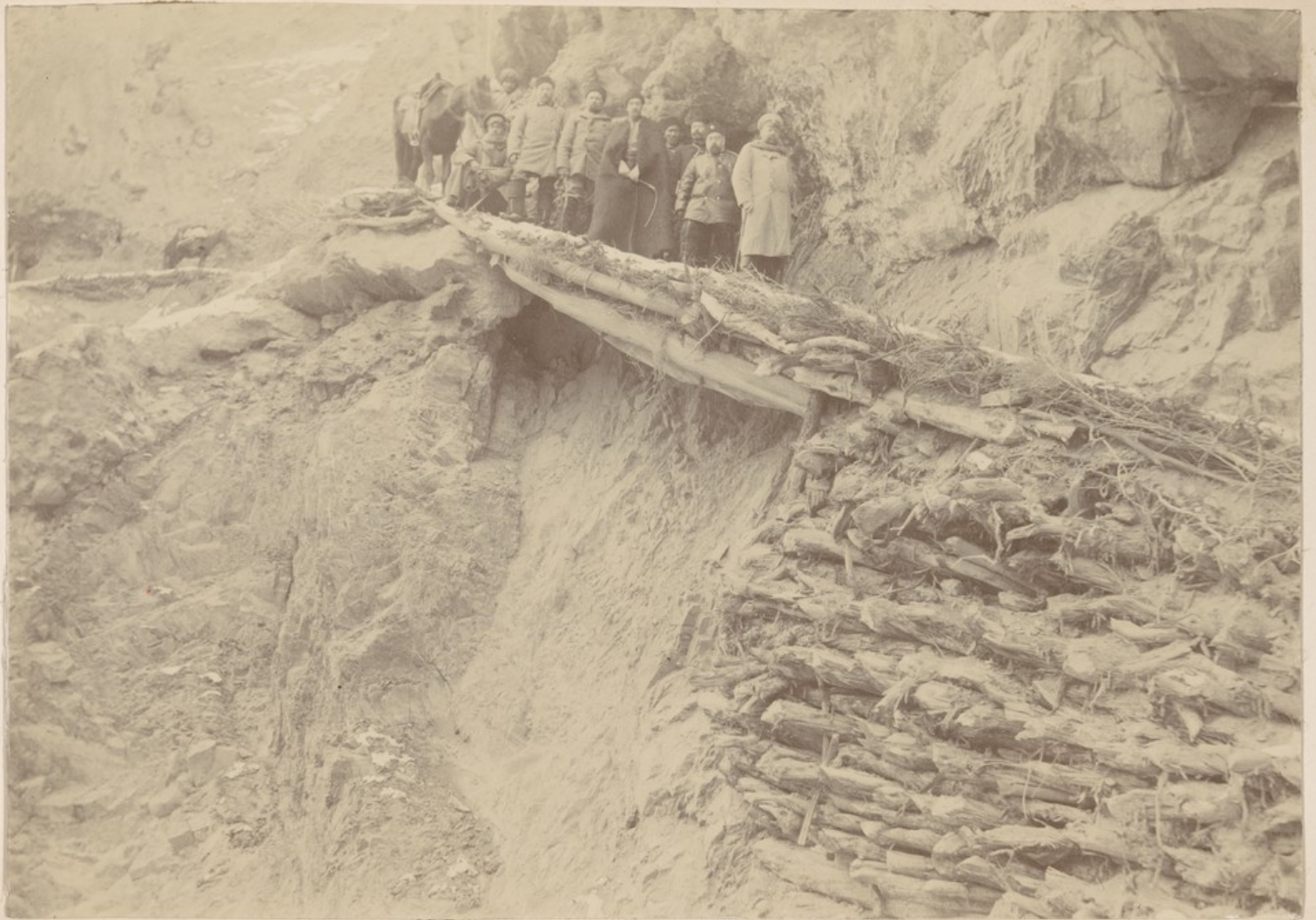
13. Балконъ на Франскомъ карнизѣ.
