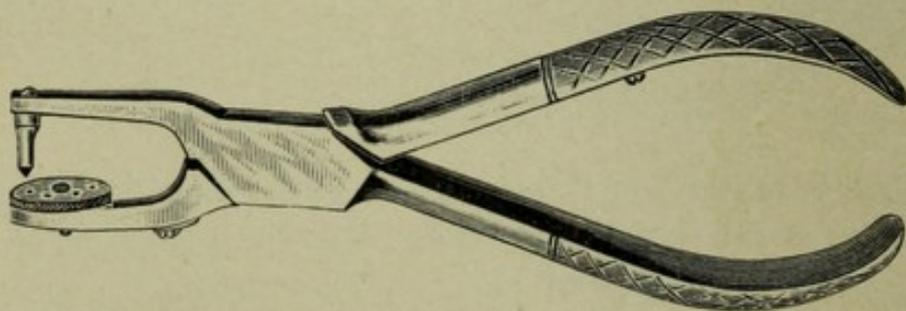
Fig. 104. Lochzange für den Cofferdam.
