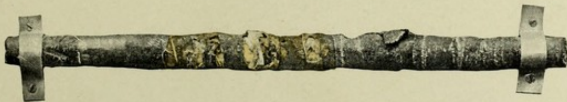
Fig. 132. Ungenügender Isolationsmantel (des berührten Kabels), an mehreren Stellen durchgeschlagen und verbrannt.
