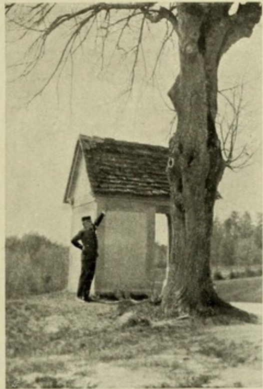
Fig. 206. Mauerwerk kanalförmig durchlöchert.
