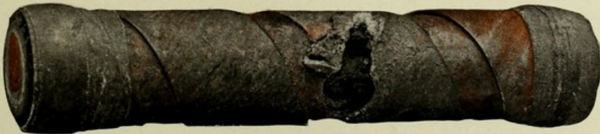
Fig. 166. Bahnspisekabel, 240 \text{ mm}^2 Querschnitt und 500 Volt Betriebsspannung (Gleichstrom). Durchschlag gegen die Erde infolge vorhergegangener mechanischer Beschädigung (Hiebe mit Erdhaue).
