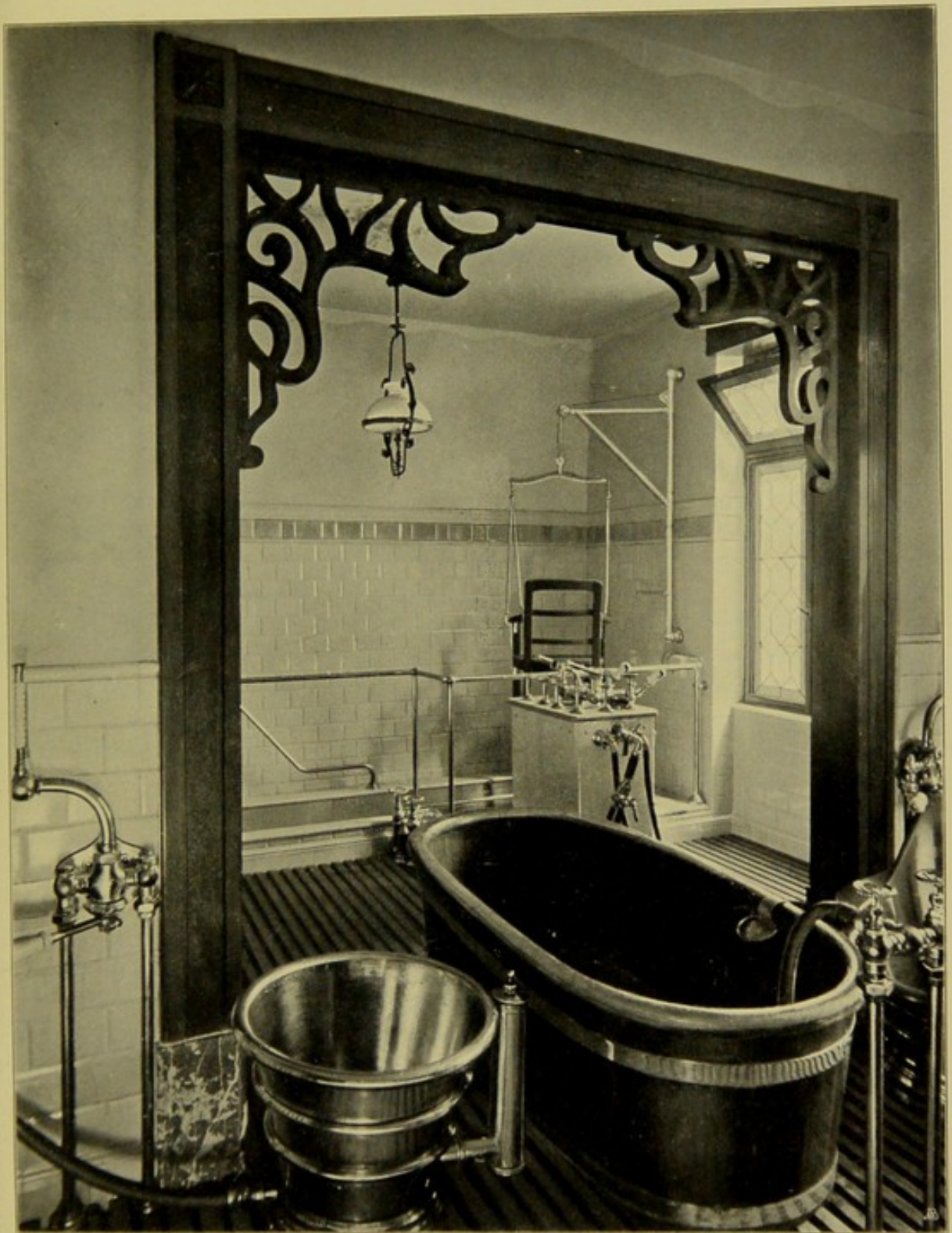
Raum für Kaltwasser-Applikationen etc.
