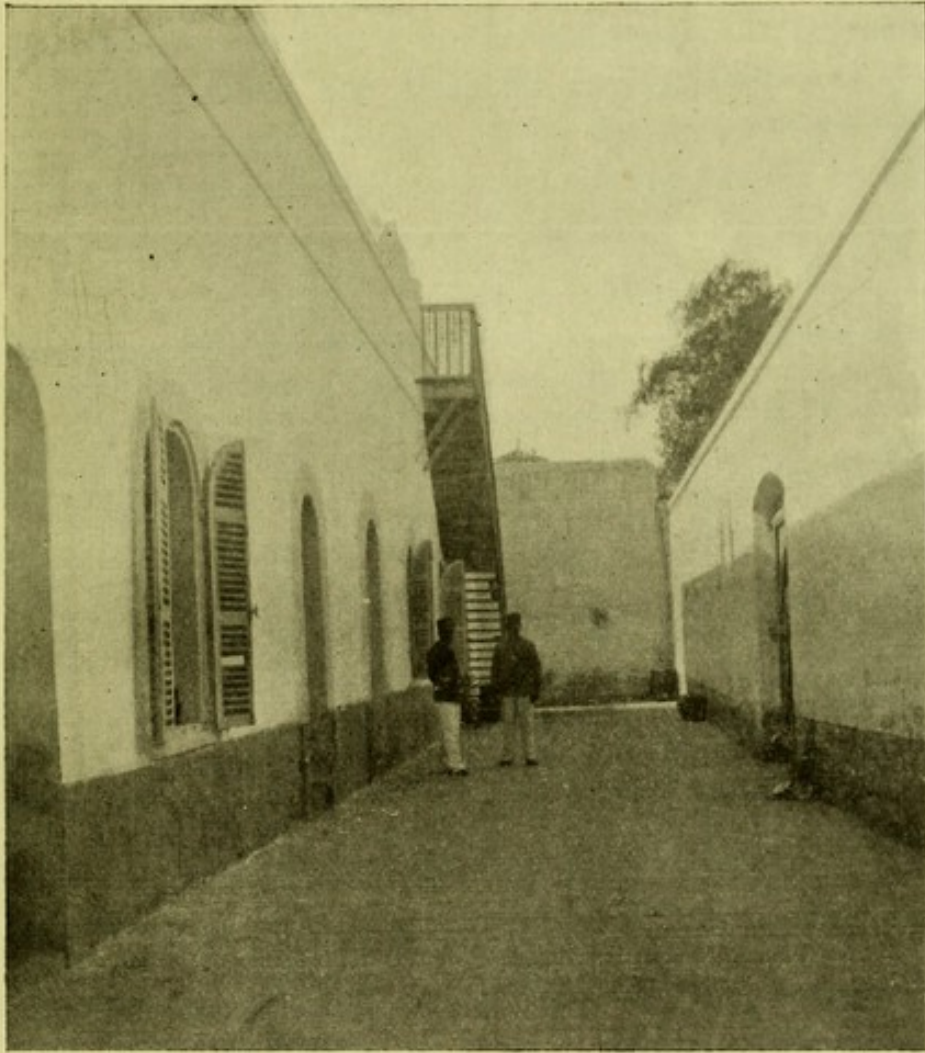
PLANCHE VIII. — Cour de prison à Biskra. On y voit un escalier en bois qui a servi pour les expériences.
