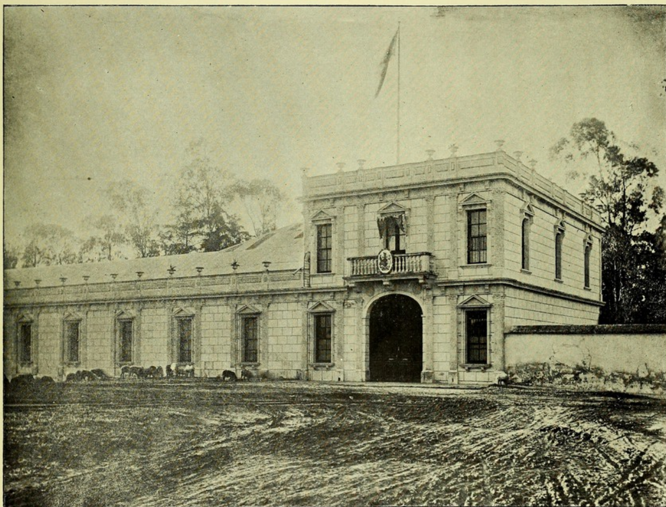
EDIFICIO DE LA LEGACIÓN INGLESA
