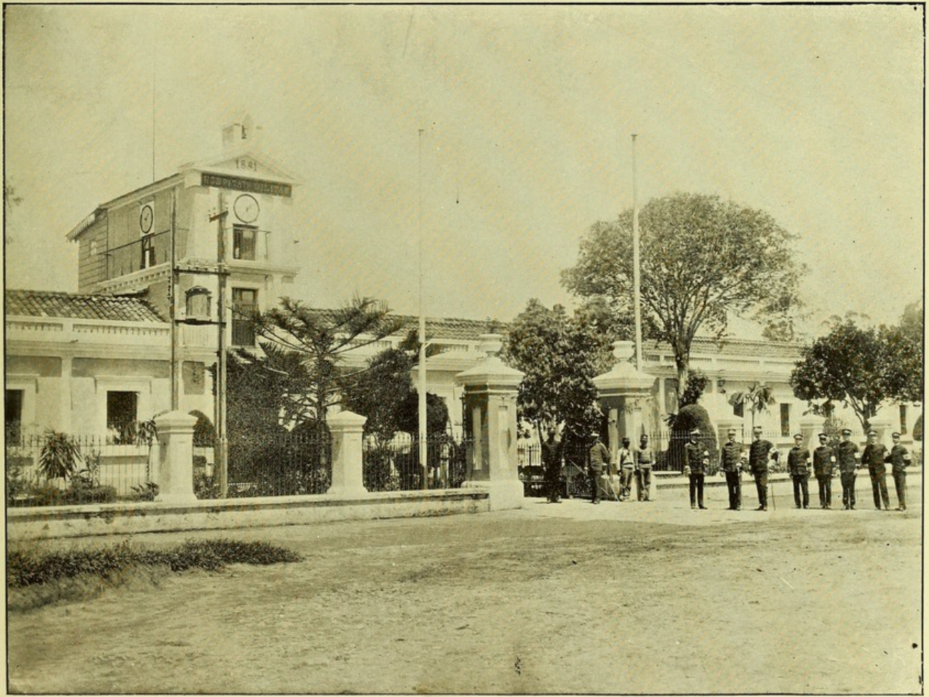
HOSPITAL MILITAR - EXTERIOR
