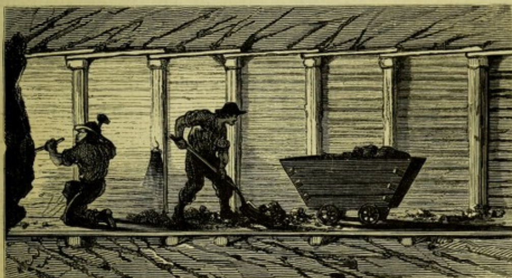
Fig. 35. — Vue longitudinale d'une galerie boisée.
