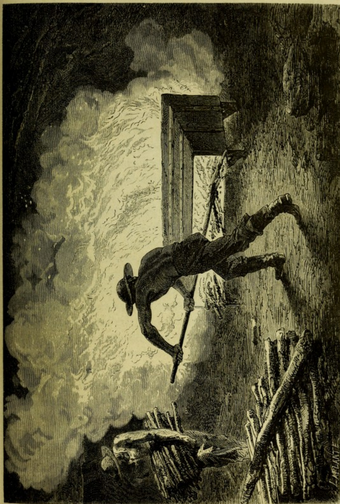
Fig. 130. — Attaque des roches par le feu.
