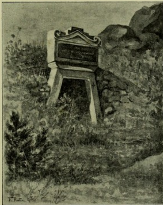
Fig. 4. Portal des vom Grafen Sternberg zum Zwecke der Erforschung des Kammerbühles angelegten Stollenbaues.
