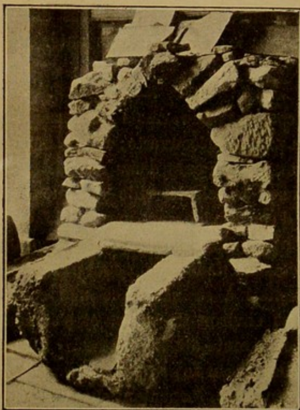
Fig. 60. — AQUEDUC DE NÉRIS.
