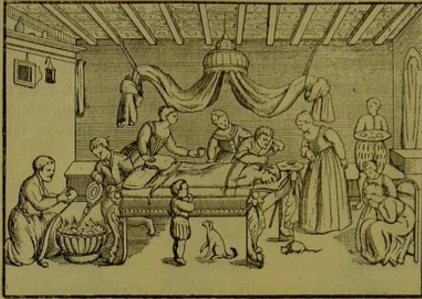
FIG. 42. — Opération crânienne au XVI<sup>e</sup> siècle, d'après Andrea a Cruce. Le chirurgien se sert d'un trépan à arbre excentrique.
