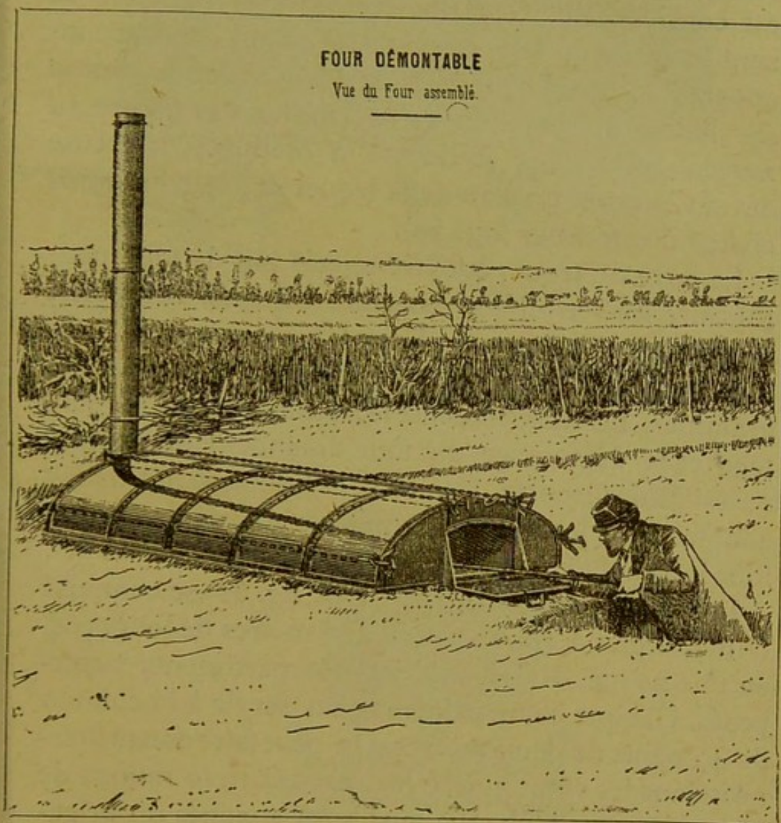
Fig. 50. — Four démontable de campagne, adopté par l'armée française Système Geneste, Herscher et Somasco. Appareil monté sur un sol quelconque et prêt à fonctionner.
