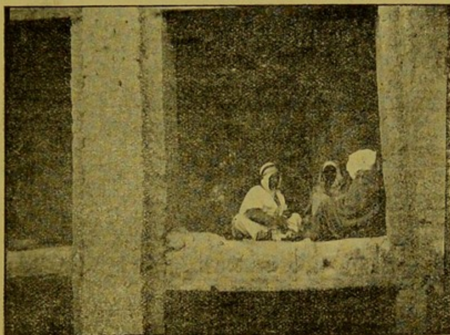
Fig 10. — Premier étage d'une maison de Beni-Ounif
