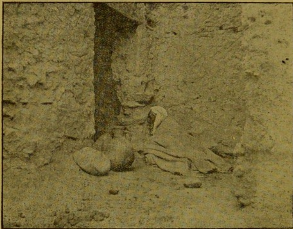
Fig. 9. — Maison du qçar de Beni-Ounif. Murs crevassés où se logent les Argas
