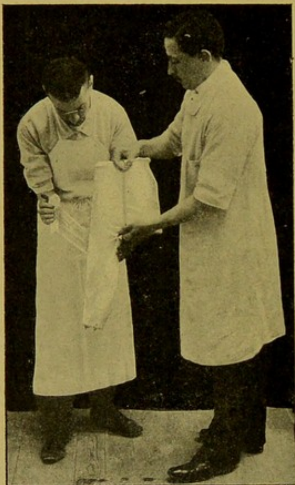
Fig. 132. — Le moulage négatif enlevé, on en rapproche les bords avec une bande de mousseline molle.
