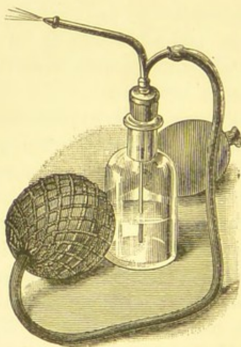
Fig. 8.—Hand-ball Spray Apparatus.
