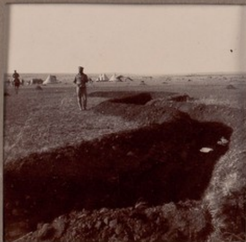
An S. Trench.
