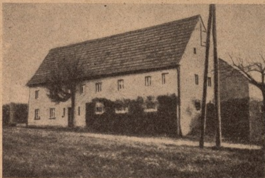
Abb. 3. Feuchter Stall Die durchfeuchtete Stallwand erscheint schwarz
