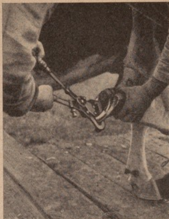
Abb. 23. Abzwicken des Hornrandes mit der Klauenzange
