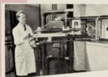
Het inzetten van een nieuw trefplaat
